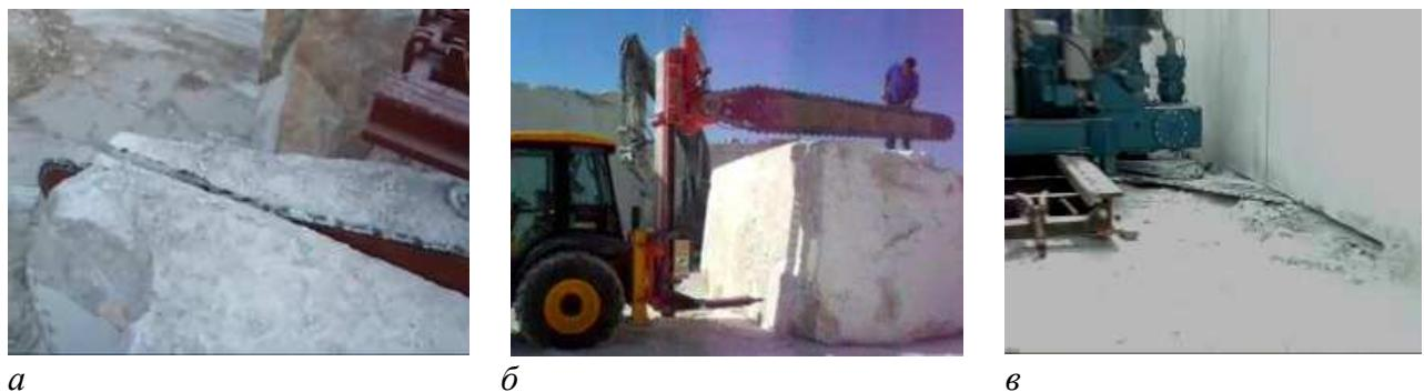
Рис. 6.6. Направления прорезки щелей баровой машиной
