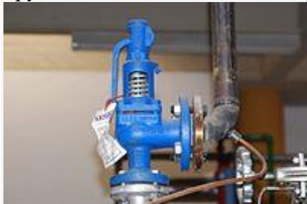
пружинный клапан Рычажно – грузовой клапан
