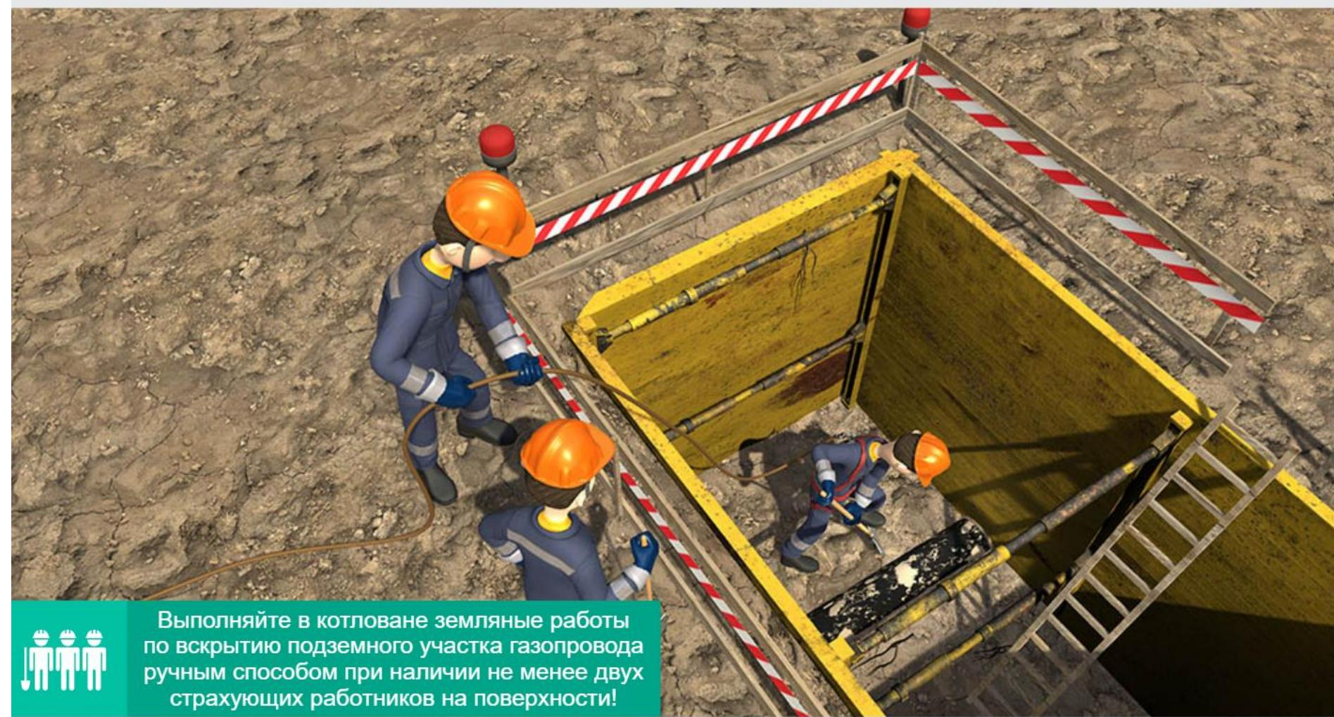
Выполняйте в котловане земляные работы по вскрытию подземного участка газопровода ручным способом при наличии не менее двух страхующих работников на поверхности!
